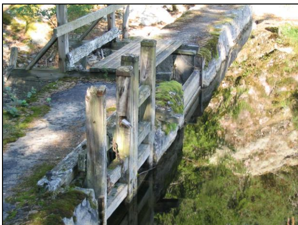
Dammen med reguleringsmuligheter.
