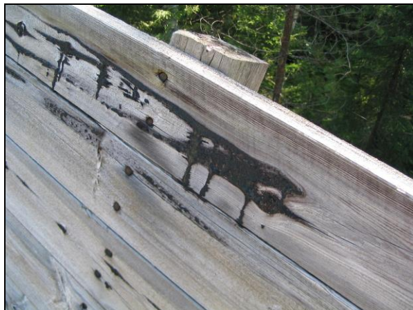
En del er bygd av kreosotimpregnerte materialer.
