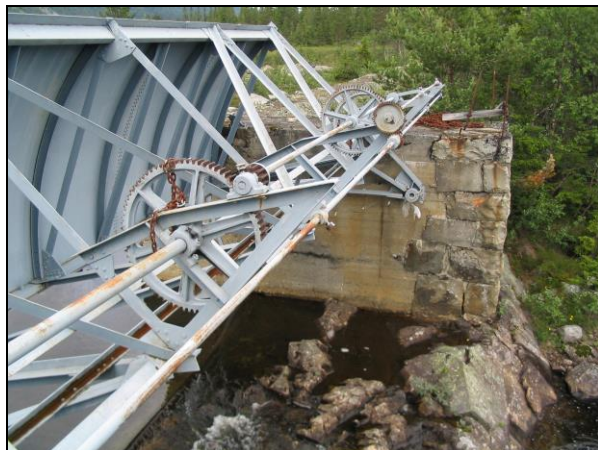
Reguleringsmekanismen sveives for hånd, og luka be- veges ved hjelp av en vaier.
