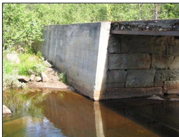
Mellom lukeåpningene er det støpt på tetting hele veien på oppstrøms side.
